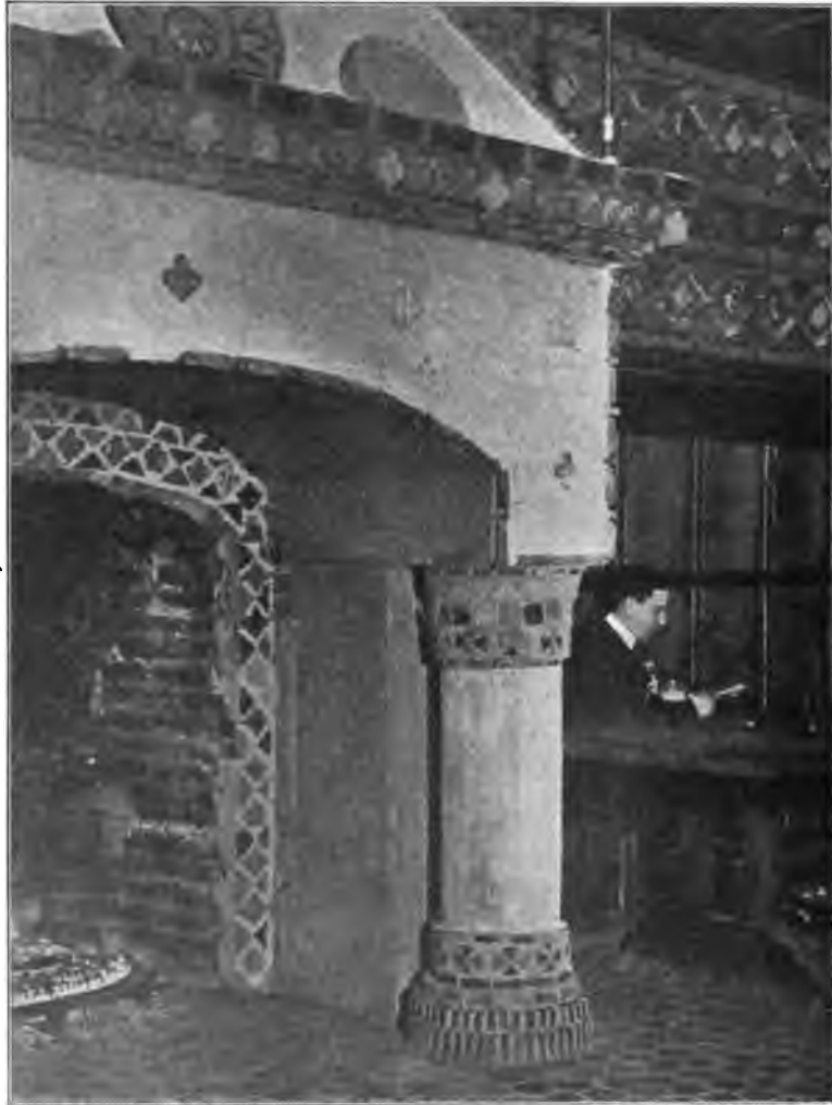
Abb. 137. Kamin aus Beton in einem amerikanischen Landhause, mit eingelegten farbigen Tonplättchen verziert, angeblich nach italienischem Vorbild des 14. Jahrhunderts.
